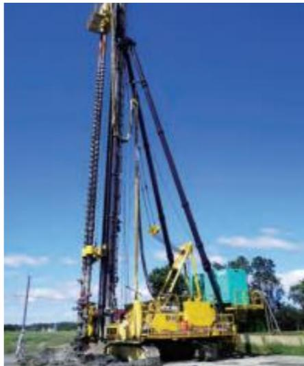
道央圏連絡道路・北海道南幌町：道路新設に際し、盛土部基礎の地盤改良工事を施工しました。
