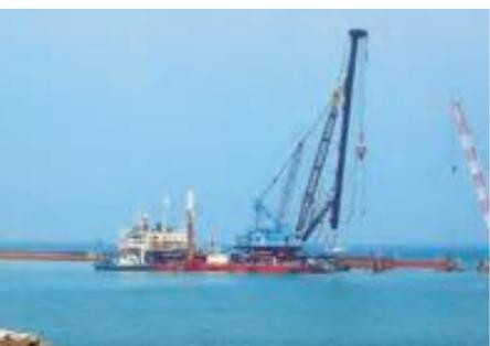
埋立造成地・愛媛県四国中央市：海上を埋立てて造成工事で、遮水鋼矢板を施工しました。
