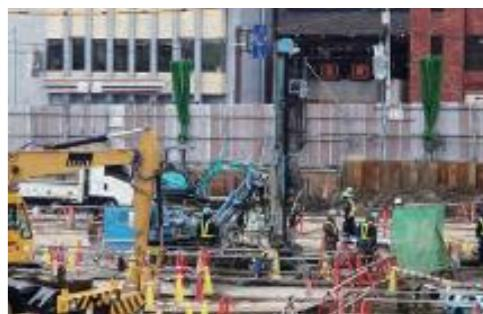
ビル新築工事・東京都新宿区：ビル新築工事で、建物軸体安定のための永久アンカーを施工しました。
