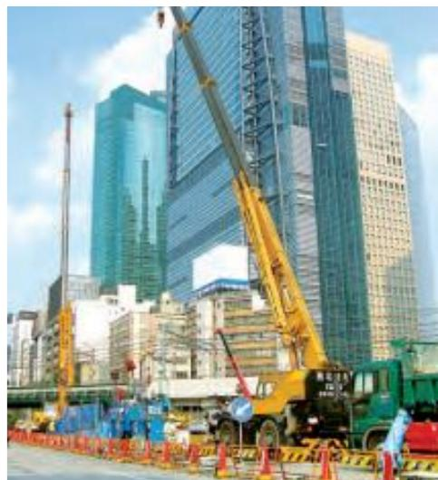
環状2号線 新虎通り・東京都港区新橋：新虎通りの整備工事の一環で、都営地下鉄浅草線との地下交差部で地下鉄線を防護するためジェットグラウト工法を施工しました。
