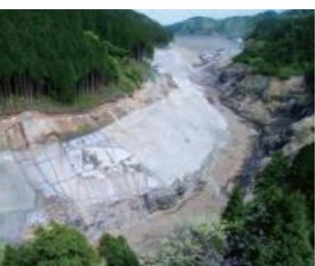
大蘇ダム・熊本県産山村：農業用ダム貯水池からの地山浸透を抑制するためにコンクリート吹付を施工しました。
