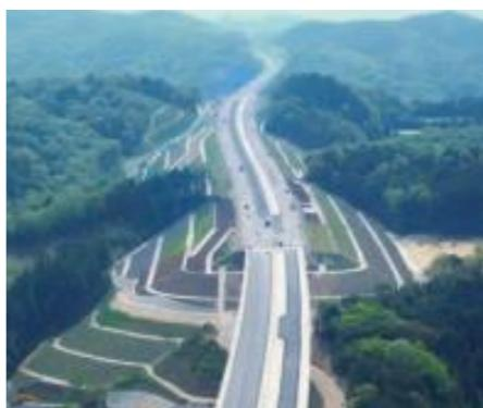
新東名高速・愛知県岡崎市：新設高速道路で、切土斜面の法面保護工事を施工しました。
