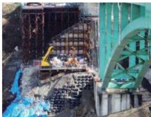
上信越道・新潟県妙高市：高速道路4車線化に伴う新設橋脚基礎構築のために、薬液注入工事を施工しました。
