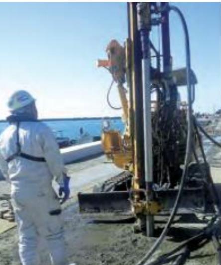
金沢港埠頭・石川県金沢市：岸壁の吸出し防止のために超多点注入工法を施工しました。
