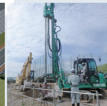
法肩での試験施工状況
