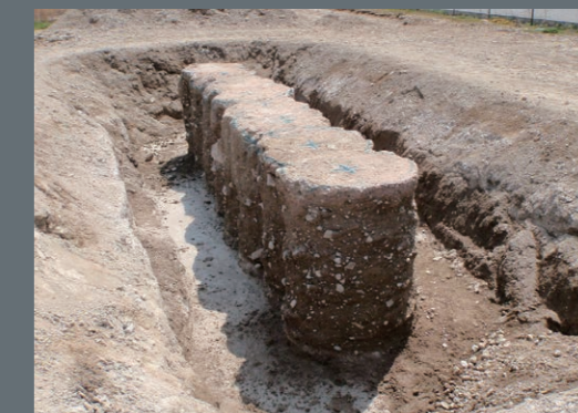
掘出し調査による出来型の確認状況
