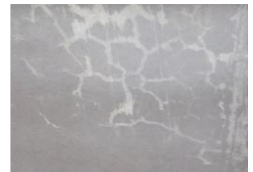
ひび割れ箇所に吹付け
