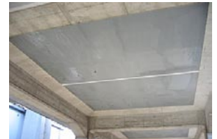
高架橋床版への適用
