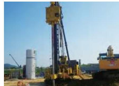
排水機場・宮城県石巻市：震災復興に伴う土地利用改変で新設する排水機場の地盤改良工事を施工しました。
