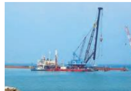
埋立造成地・愛媛県四国中央市：海上を埋立てる造成工事で、遮水鋼矢板を施工しました。
