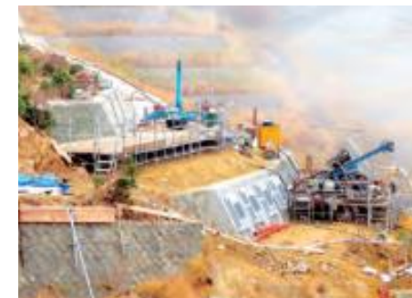
大涌沢地域・神奈川県箱根町仙石原：年間2000万人が訪れる観光地・箱根大涌谷で、地すべり対策として、アンカー工事をを行い観光資源を守っています。
