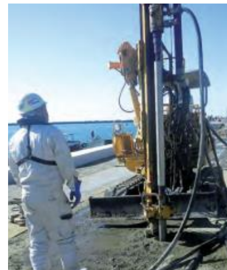
金沢港埠頭・石川県金沢市：岸壁の吸出し防止のために超多点注入工法を施工しました。
