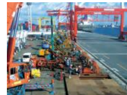
127,100m 3 をわずか6ヶ月で施工
