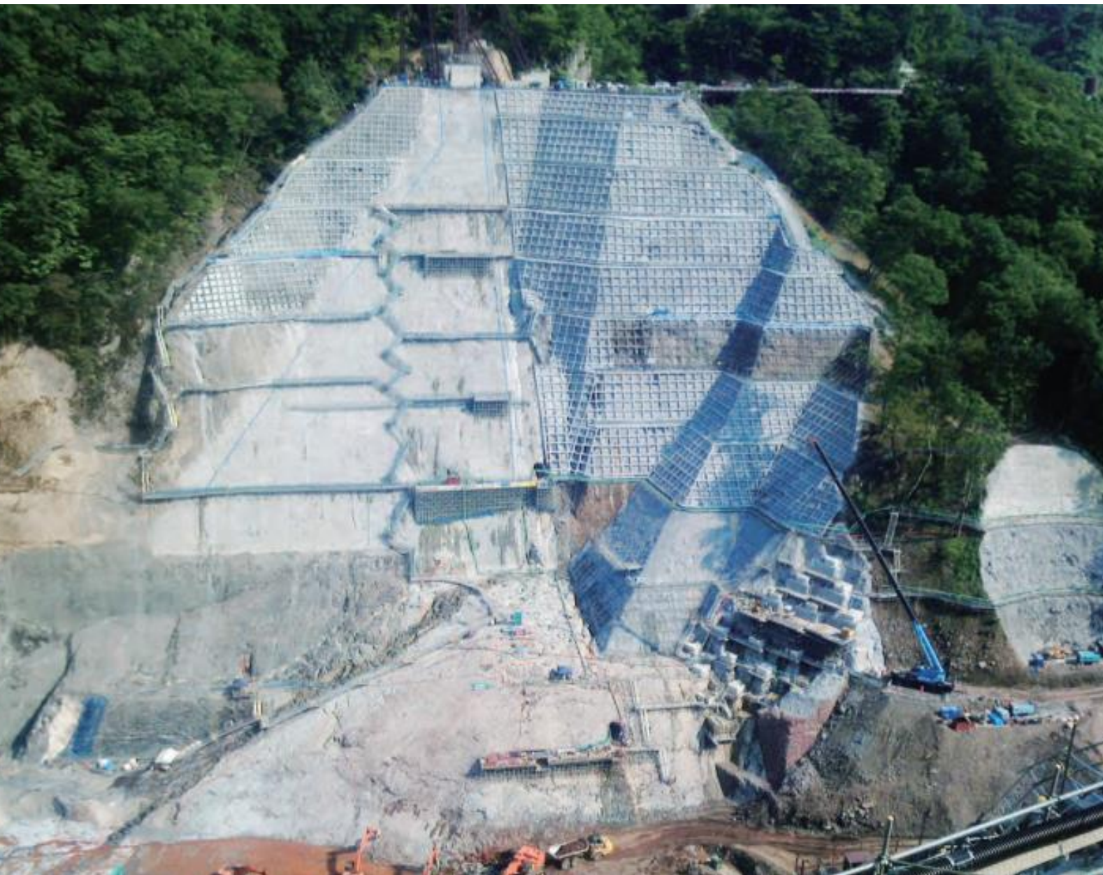
ハッ場ダム・群馬県吾妻郡長野原町：洪水調節、水道及び工業用水の確保並びに発電を目的とする建設中の多目的ダムです。当社は法面保護工事を施工しています。
