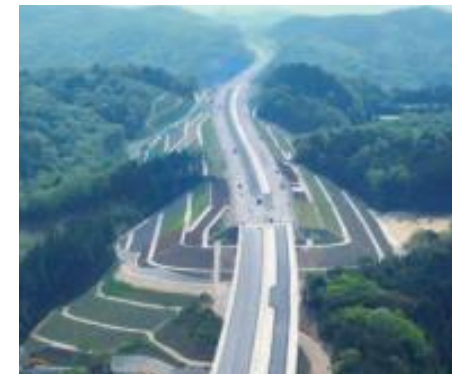
新東名高速・愛知県岡崎市：新設高速道路で、切土斜面の法面保護工事を施工しました。
