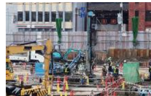
ビル新築工事・東京都新宿区：ビル新築工事で、建物躯体安定のための永久アンカーを施工しました。
