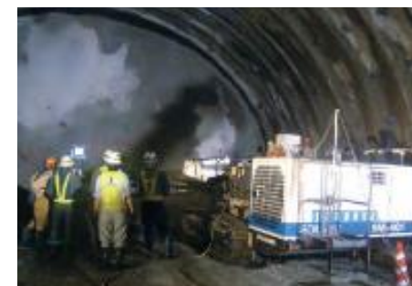
京都府野田川大宮第14トンネル・山陰近畿自動車道：道路トンネルの掘削前の調査において地山の性状を確認するため水圧ハンマーによる高速ボーリングを実施しました。
