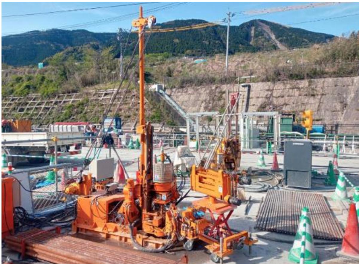
堤体アバット上での施工
