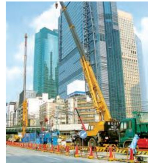
環状2号線 新虎通り・東京都港区新橋：新虎通りの整備工事の一環で、都営地下鉄浅草線との地下交差部で地下鉄線を防護するためにジェットグラウト工法を施工しました。
