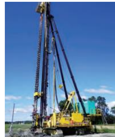
道央圏連絡道路・北海道南幌町：道路新設に際し、盛土部基礎の地盤改良工を施工しました。
