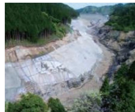
大蘇ダム・熊本県産山村：農業用ダム貯水池からの地山浸透を抑制するためにコンクリート吹付を施工しました。
