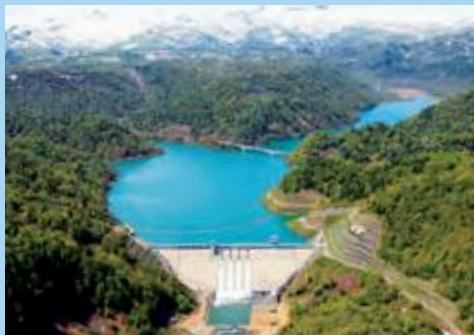
徳富ダム・北海道樺戸郡新十津川町：平成25年に完成した、洪水調節・かんがい用水・水道用水の供給を目的とした多目的ダムです。当社はダムグラウチング技術で完成に寄与しました。
