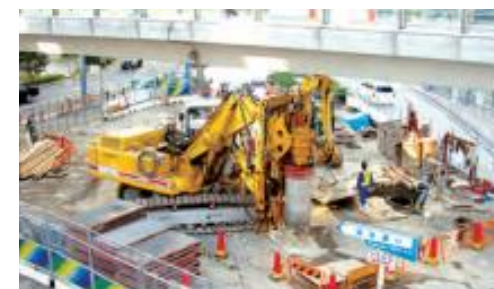
汐留交差点・東京都港区：再開発に伴う地中障害物撤去で、歩道橋下を低空頭仕様のBG機で施工しました。
