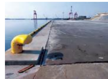
震災後の液状化対策工事追跡調査
