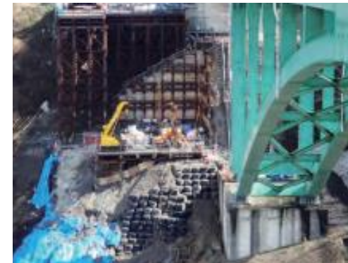
上信越道・新潟県妙高市：高速道路4車線化に伴う新設橋脚基礎構築のために、薬液注入工事を施工しました。
