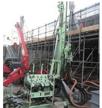
写真-3 スキッド型削孔機
