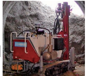
写真-2 小型クローラ型削孔機
