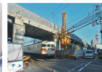
鉄道近接での施工(低空仕様)
