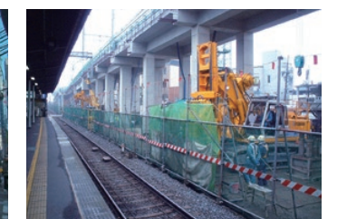
高架下、鉄道近接での施工(低空仕様)
