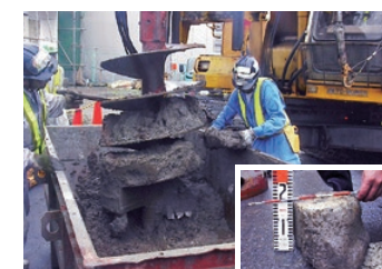
オーガー掘削(ガラ、玉石等)
