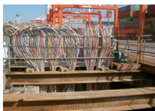
注入管を集積して、占用範囲を極小化
