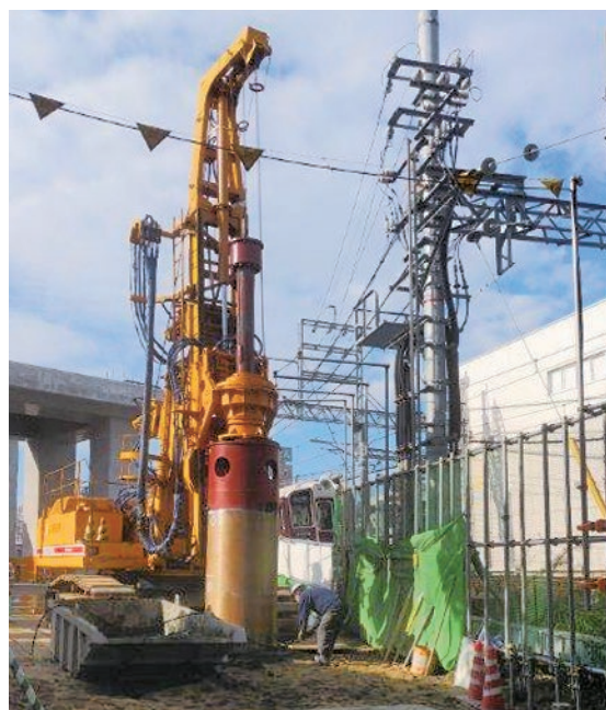
BG-7 9.6mマスト φ1000mm 掘削長 L=9.0m
