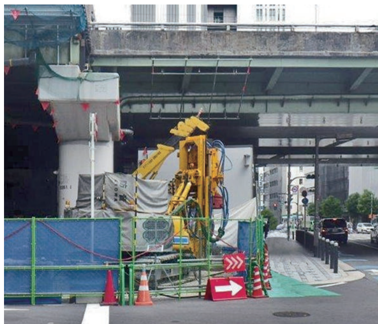
BG-7 4.7mマスト φ650mm 掘削長 L=5.0m
