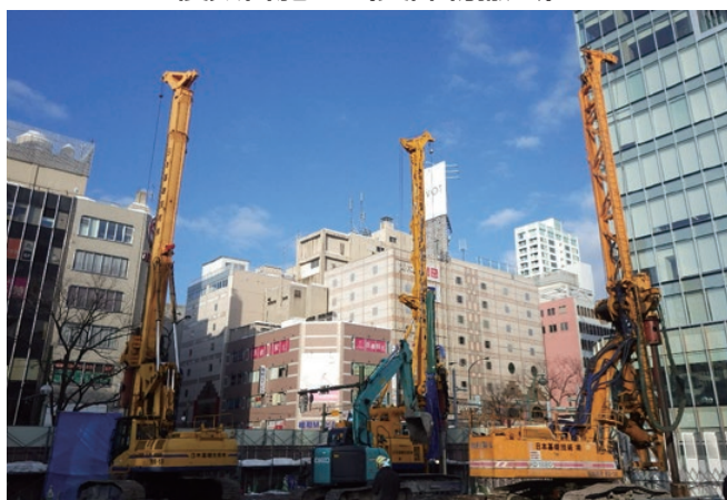
NK-18 φ750 mm BG-20 φ750 mm BG-14 φ650 mm 掘削長 L=13.0m
