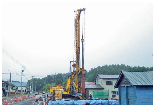
BG-14 φ780 mm（場所打杭） φ550 mm（山留杭）掘削長 L=9.0m
