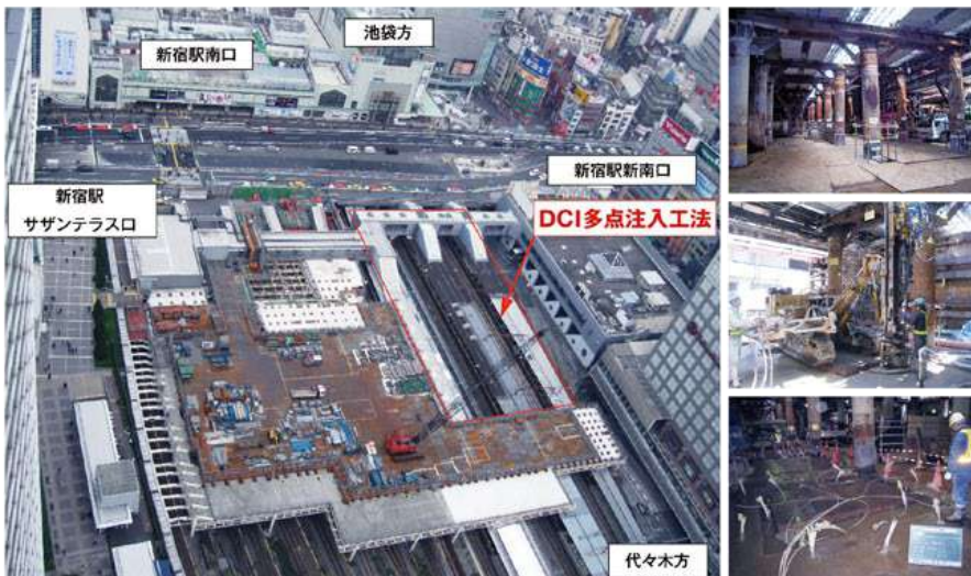
新宿駅南口地区人工地盤新設工事
