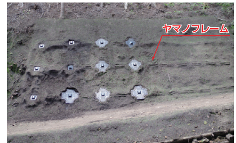
植生基盤吹付完了
