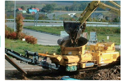
一次破碎作業
