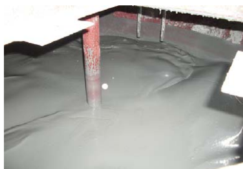
グラウトミキサー(アジテータ状況)
