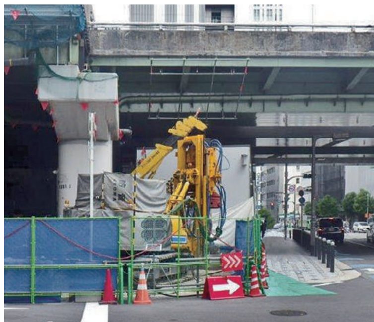
BG-7 4.7mマスト φ650mm 掘削長 L=5.0m
