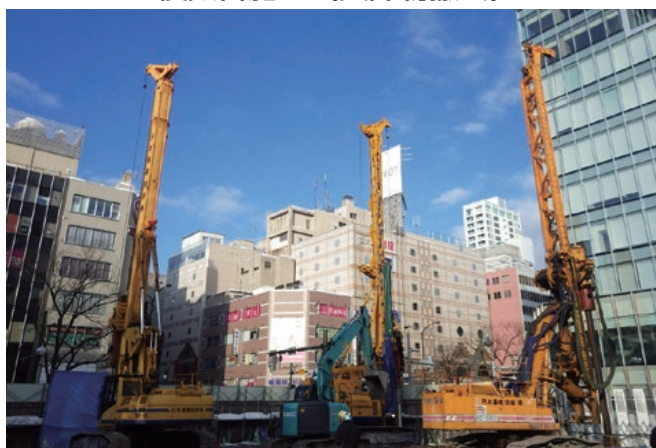
NK-18 φ750 mm BG-20 φ750 mm BG-14 φ650 mm 掘削長 L=13.0m
